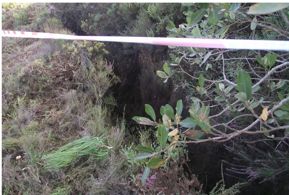
SET | Vista parcial de um troço da vala, de Sudoeste para Nordeste
