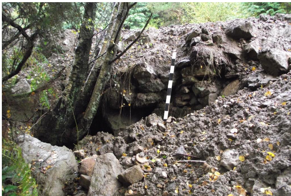
SET | Vista geral do muro de sustentação do canal, a jusante do acesso, visto de Sudoeste.
