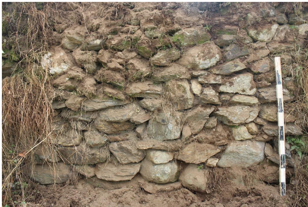
SET| Pormenor do aparelho construtivo de um muro.
