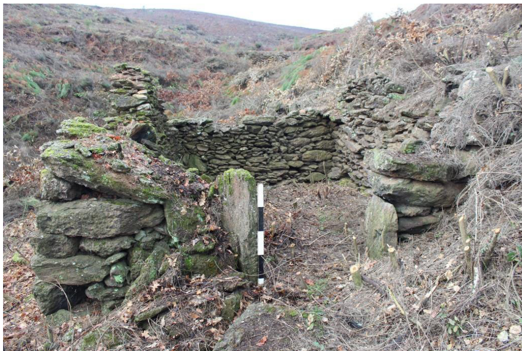
SET| Perspetiva sobre o vão da porta, localizada no alçado sudoeste do edifício.
