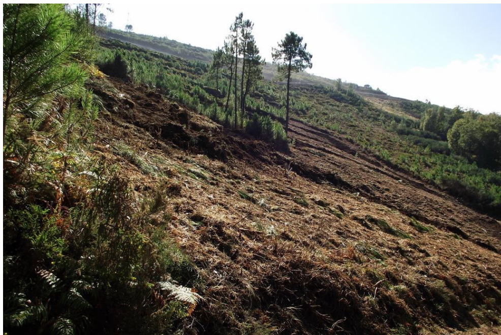
SET | Implantação da vala em encosta de pendente acentuada, vista a partir de Norte
