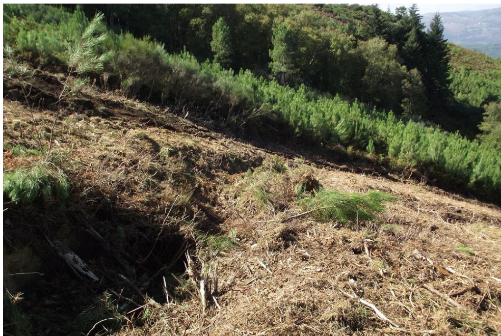
SET | Vista parcial de um troço da vala, de Este para Oeste
