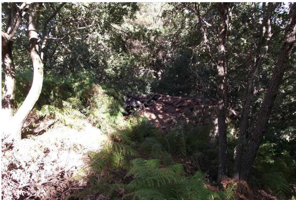
SET| Vista sobre o telhado do edifício.
