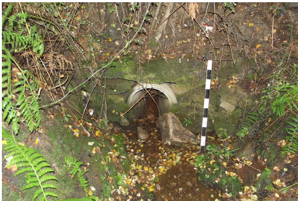
SET | Perspetiva geral da passagem hidráulica, localizada a montante, vista de Nordeste.
