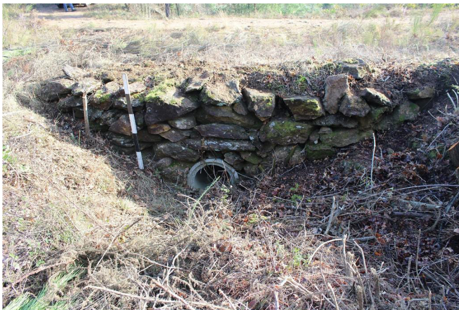
SET | Perspetiva geral da passagem hidráulica, localizada a montante, vista de Noroeste.
