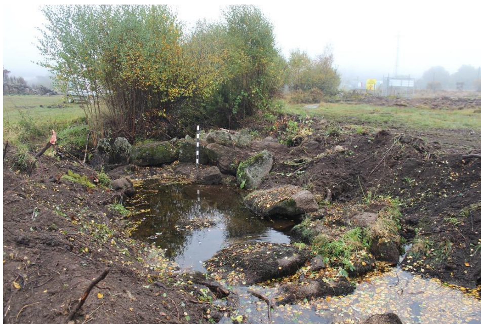
SET| Aspeto do açude visto de sudoeste.
