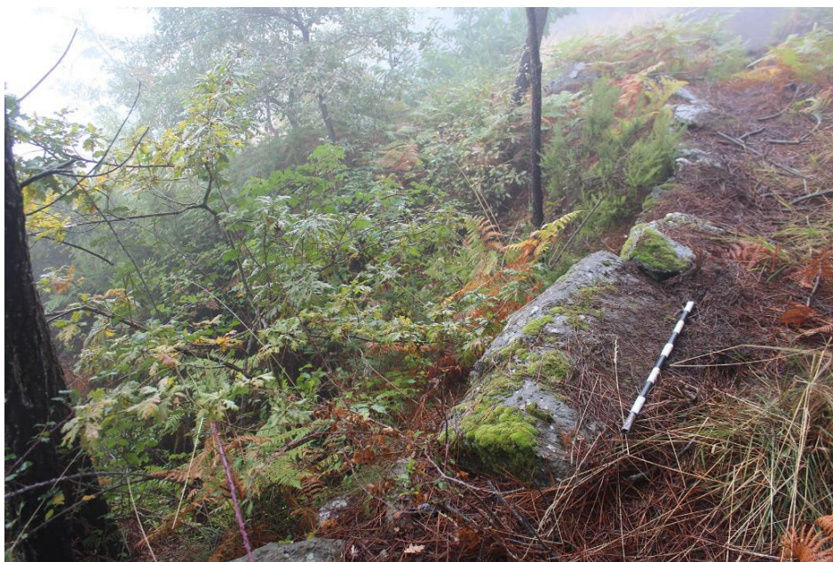
SET| Pormenor do muro de propriedade que circunda a mina.
