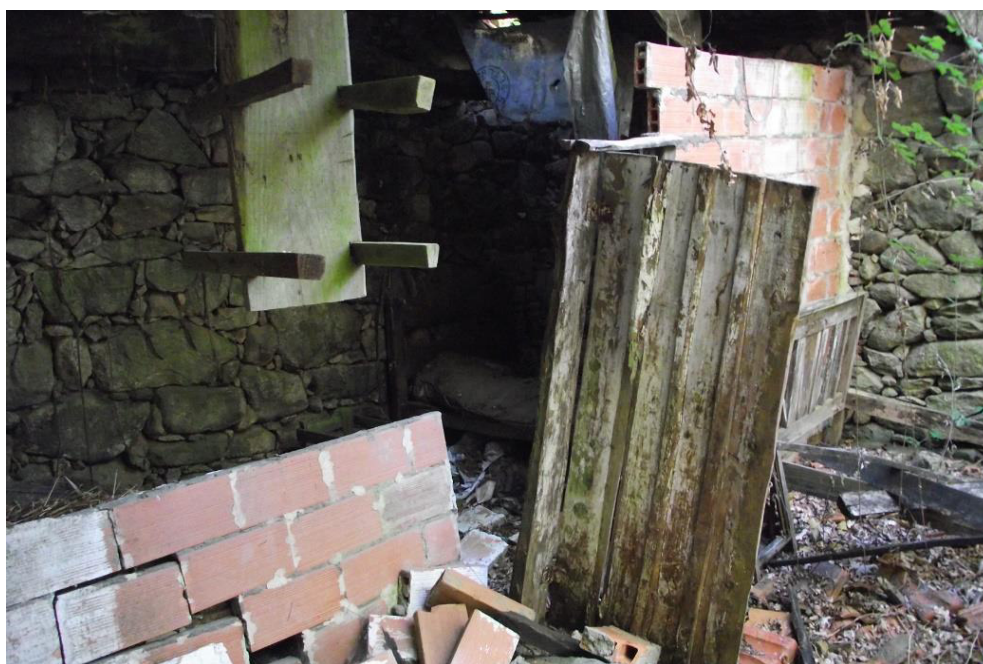
SET| Vista sobre o interior da ocorrência. Note-se a tarimba ao fundo.
