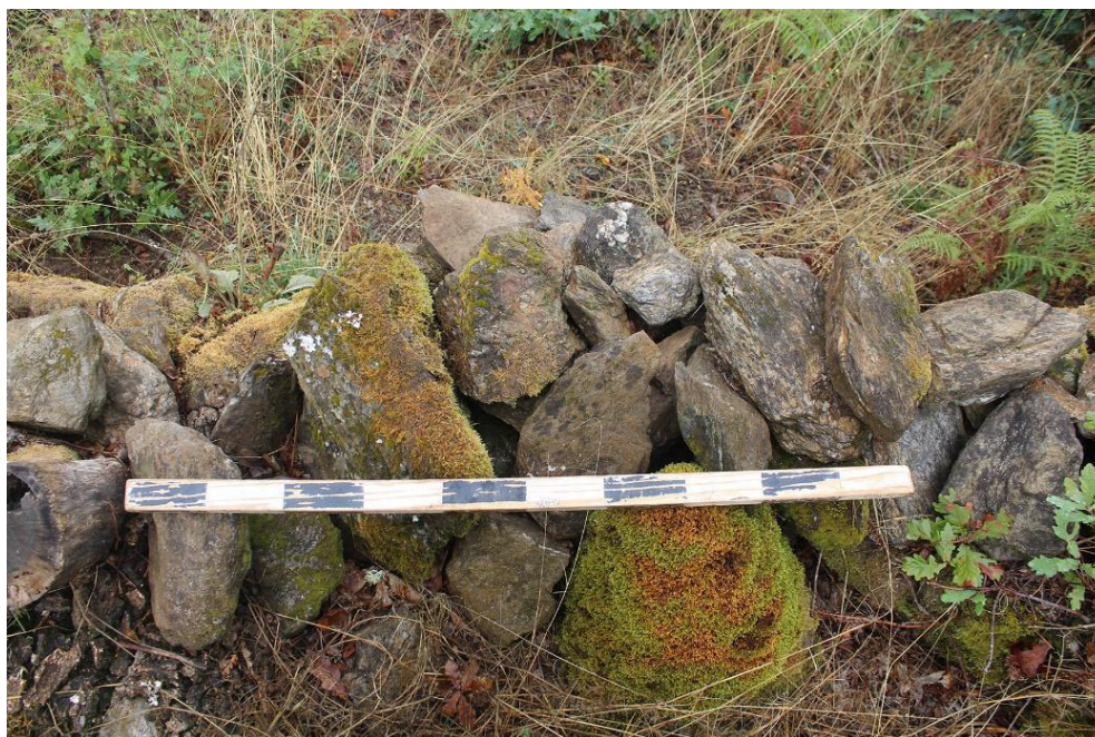
SET| Pormenor do coroamento de um muro de suporte a um socalco.
